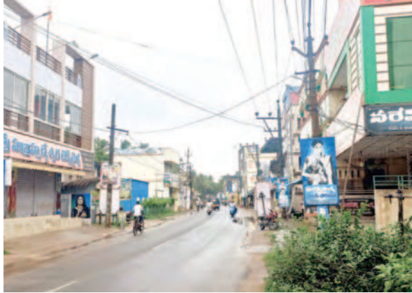
అమలాపురంలో నిర్మాణస్వంగా ఉన్న రోడ్డు
